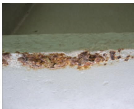
Flange edge corrosion
